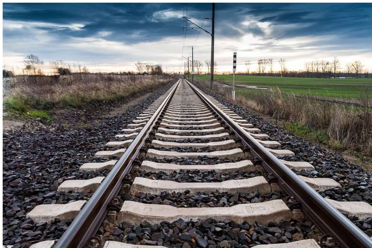
Nawierzchnia drogi kolejowej
