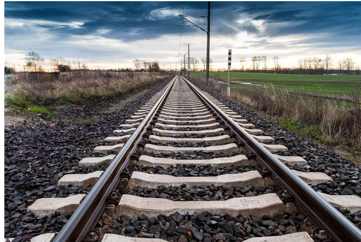
Nawierzchnia drogi kolejowej
