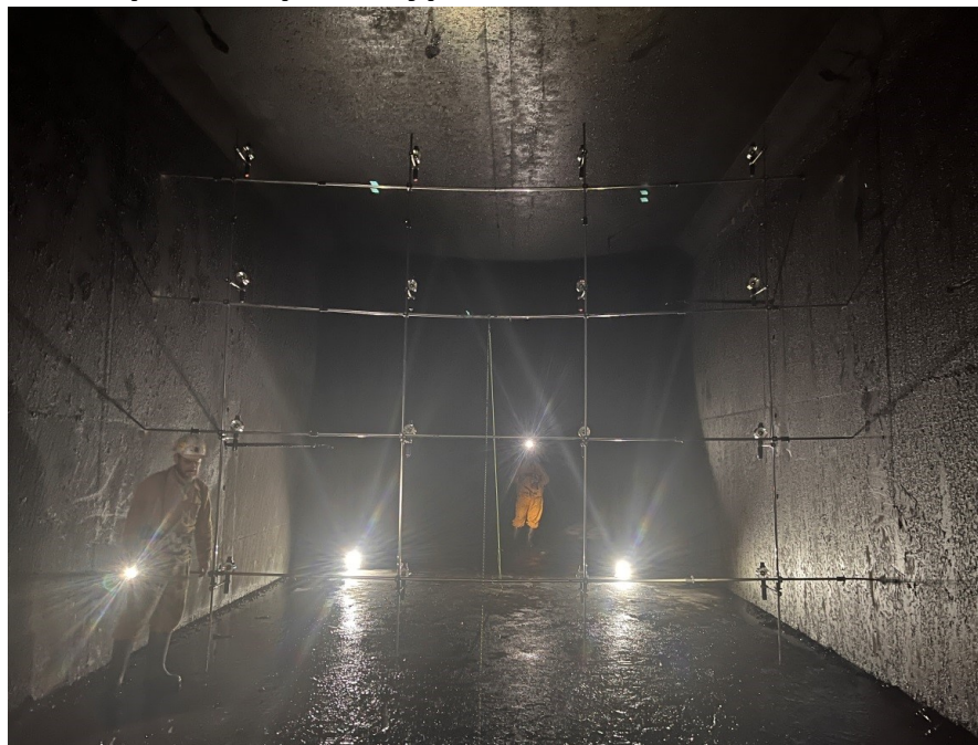
Fot. 1. Widok stanowiska pomiarowego w kanale zbiorczym szybu VI kopalni
