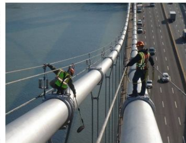
Rys. 1: Praca inspektora przeprowadzającego przeglądy obiektów mostowych wiąże się z ryzykiem i koniecznością obsługi i przenoszenia wielu urządzeń w niesprzyjających warunkach.
