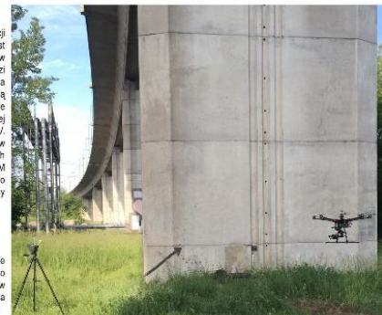
Rys. 1. Inspekcja mostu z użyciem fotogrametrii UAV
