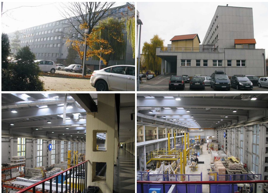
Budynek Wydziałowego Laboratorium Budownictwa w latach 2018-2019 (fot. R. Jasiński)
