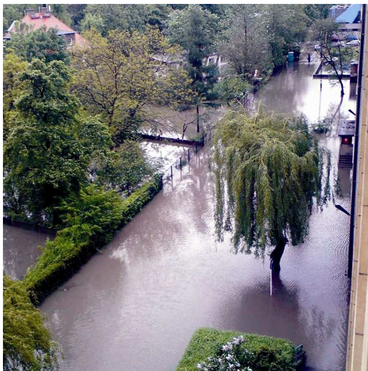
Otoczenie budynku Laboratorium Budownictwa w trakcie przejścia kulminacyjnej fali powodzi (18.05.2010 r.). Z lewej strony widoczny dach willi przy ul. Kaszubskiej 22, z prawej strony widoczny niebieski dach Hali Sportowej (fot. D. Drynda)
