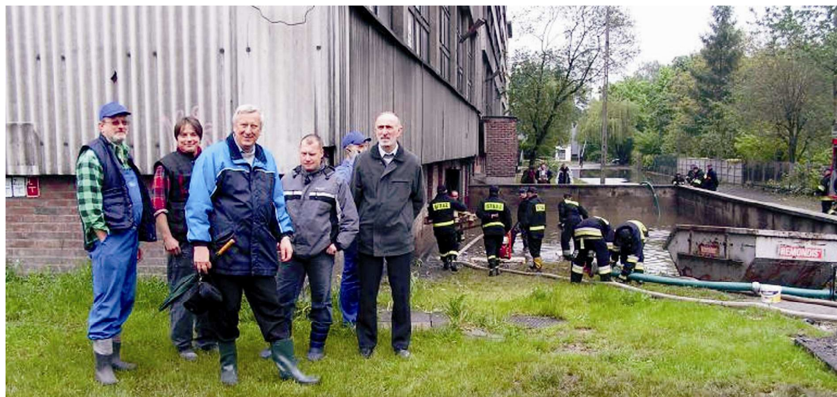
Osuszanie stacji transformatora budynku Laboratorium w maju 2010 roku. Od lewej strony stoją: Jerzy Rusiniok (konserwator), mgr inż. Grzegorz Cygan (spec. inż.-tech. w Katedrze Procesów Budowlanych), mgr inż. Aleksander Tyczewski (kierownik Laboratorium Budownictwa), mgr inż. Dariusz Drynda (spec. inż.-tech. w Laboratorium Budownictwa), dr hab. inż. Jerzy Sękowski (Dziekan Wydziału Budownictwa), w głębi przez telefon rozmawia Adam Pol (elektryk) (fot. A. Mazurek)
