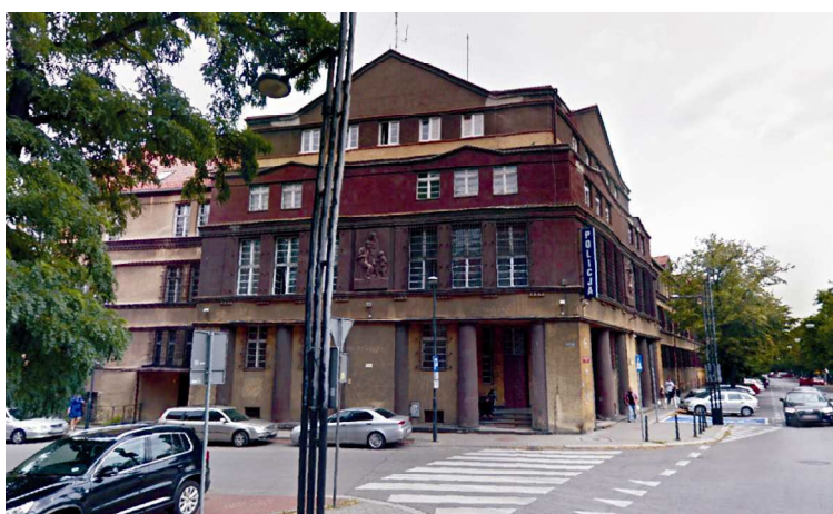
Gmach Wydziału Mechanicznego przy ul. Powstańców 12: a) w 1946 roku (fot. arch. PŚ), b) w 2019 roku (fot. R. Jasiński)
