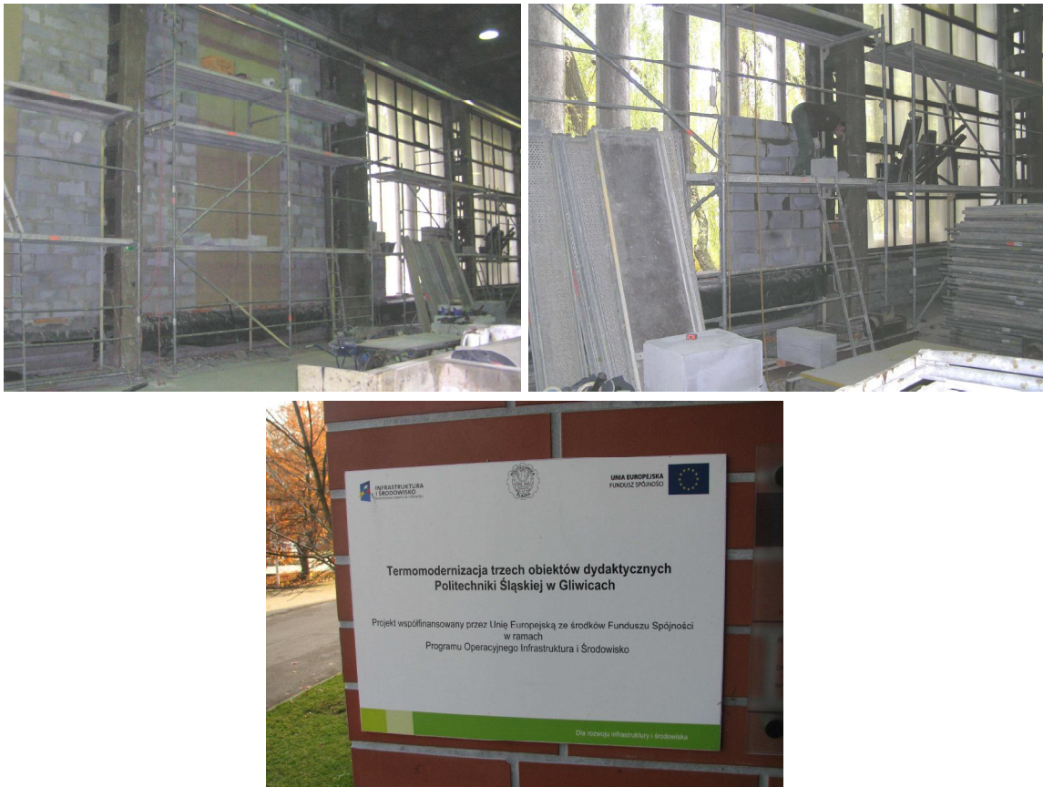
Remont przeszklenia i termomodernizacja budynku Laboratorium Budownictwa wykonana w latach 2011–2013 (fot. D. Drynda, R. Jasiński)
