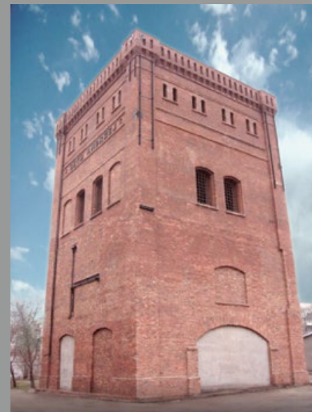
Elewacja południowa i zachodnia szybu „Andrzej” w Rudzie Śląskiej (foto. W. Oronowicz)
