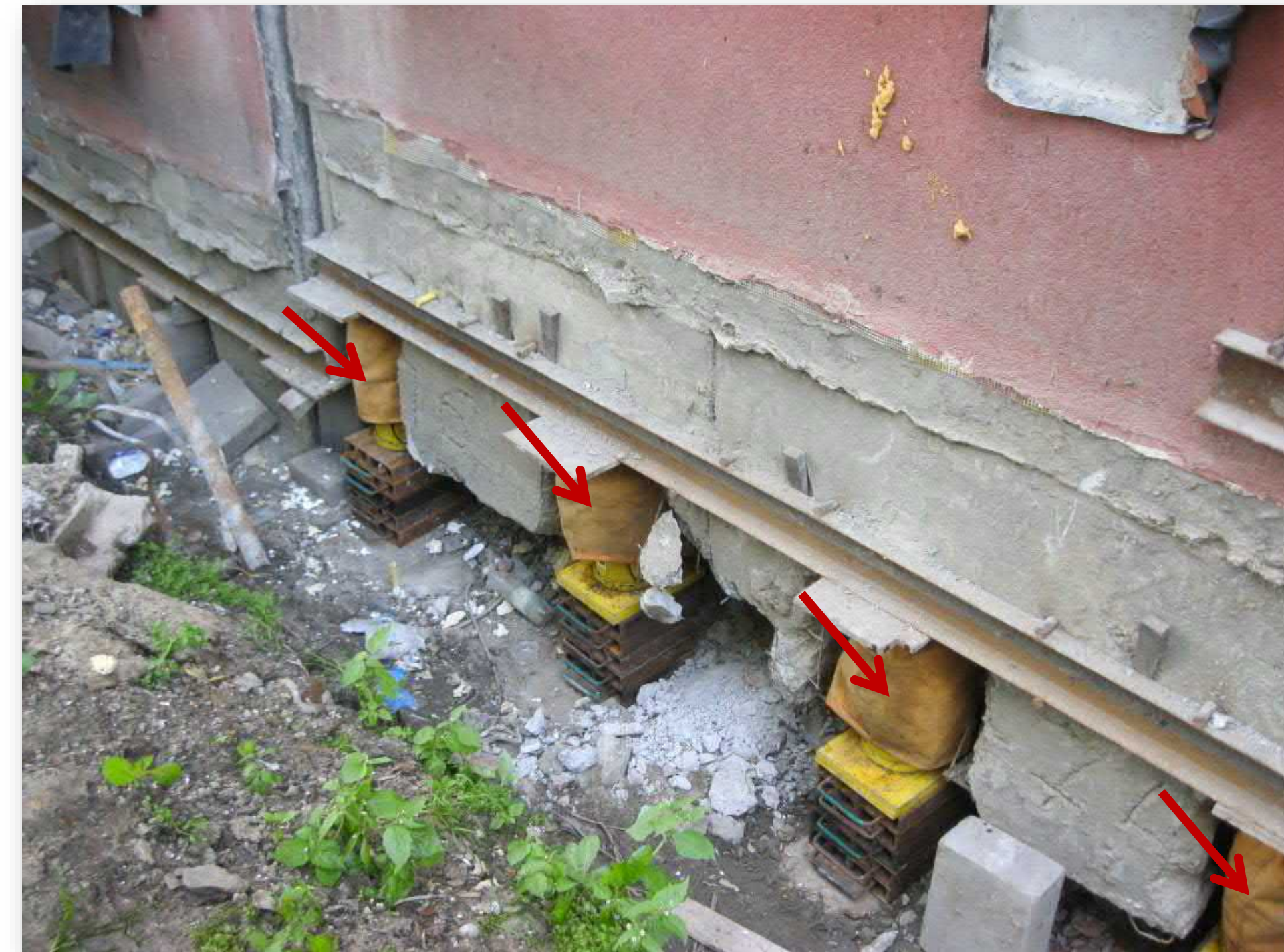
rektyfikacja obiektu budowlanego http://www.mpl.com.pl (2022)
