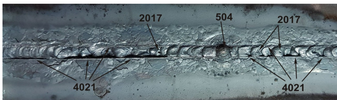
Rys. 3. Wykryte niezgodności podczas badania wizualnego złącza spawanego od strony grani spoiny: 2017 – por powierzchniowy, 4021 – niepełne przetopienie grani, 504 – wyciek
